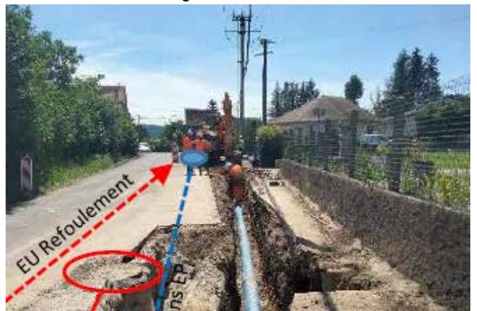
Démarrage des travaux de renouvellement des canalisations AEP (Alimentation Eau Potable) financés par le SIEGA et la mise en séparatif financée par la CAPV
